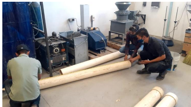
Ilustración 9 Medición y corte de columnas
