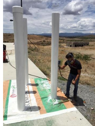
Ilustración 15 Pintado de estructura
