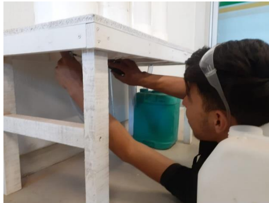
Ilustración 22 Instalación de sistemas de recolección
