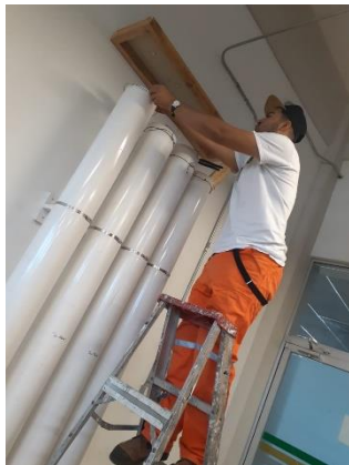
Ilustración 23 Relleno de columnas
