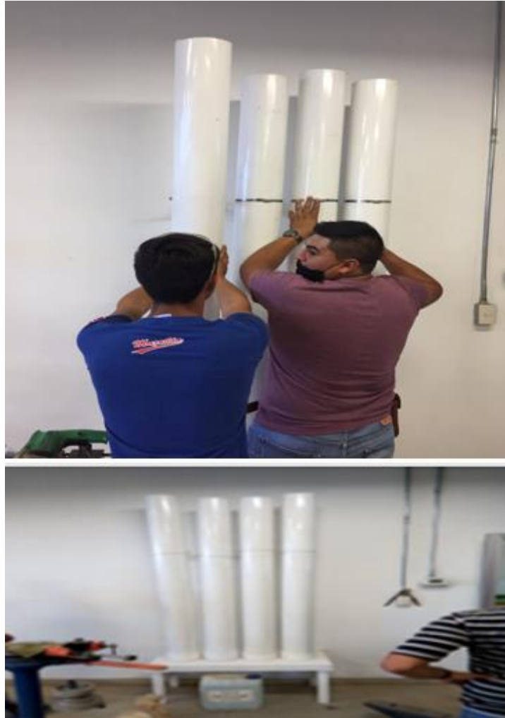
Ilustración 32 instalación de columnas
