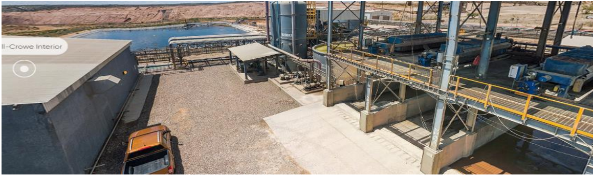
Ilustración 7. Planta Merrill Crown.
